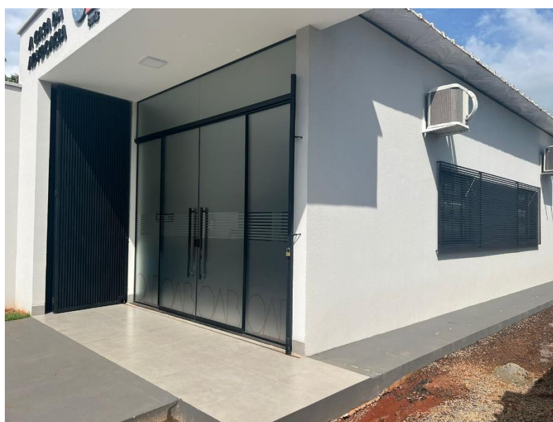
Figura 2 - Exemplo de subseção que consta brisa nas janelas e porta metálica “camarão” recuada.
