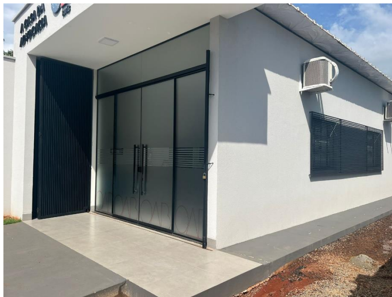
Figura 2 - Exemplo de subseção que consta brise nas janelas e porta metálica "camarão" recuada.
