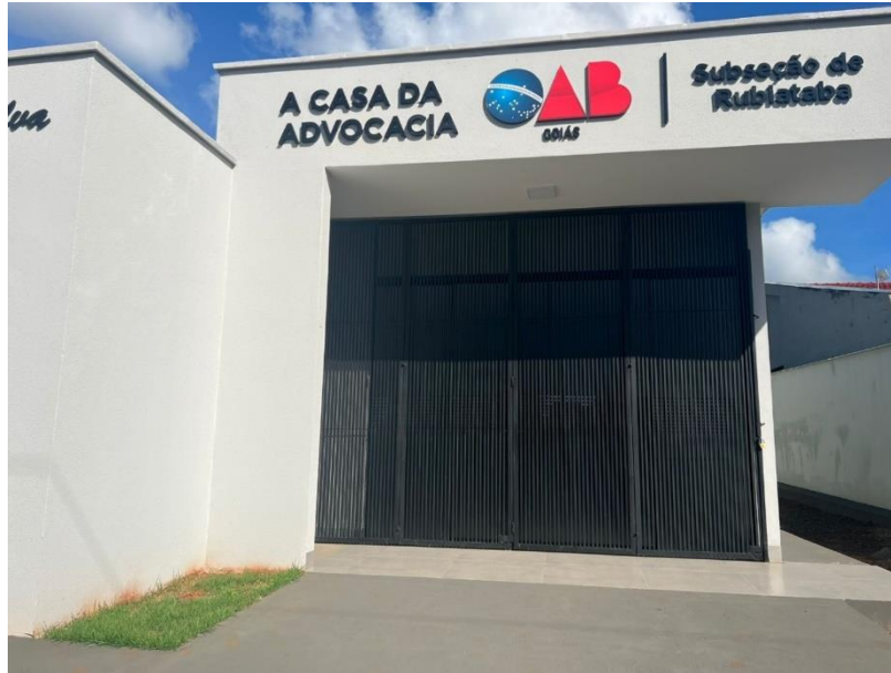
Figura 1-Exemplo de subseção que consta porta metálica (externa) com abertura “camarão”.
