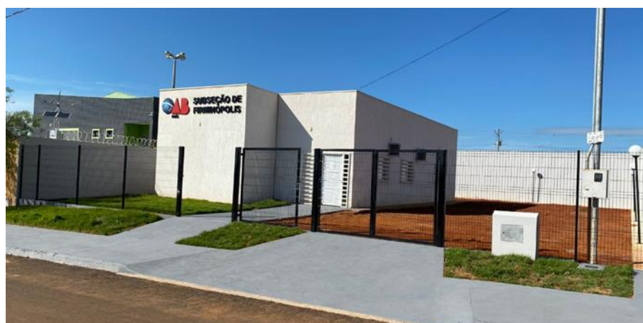
Figura 3- Exemplo de subseção que consta o gradil na fachada frontal.
