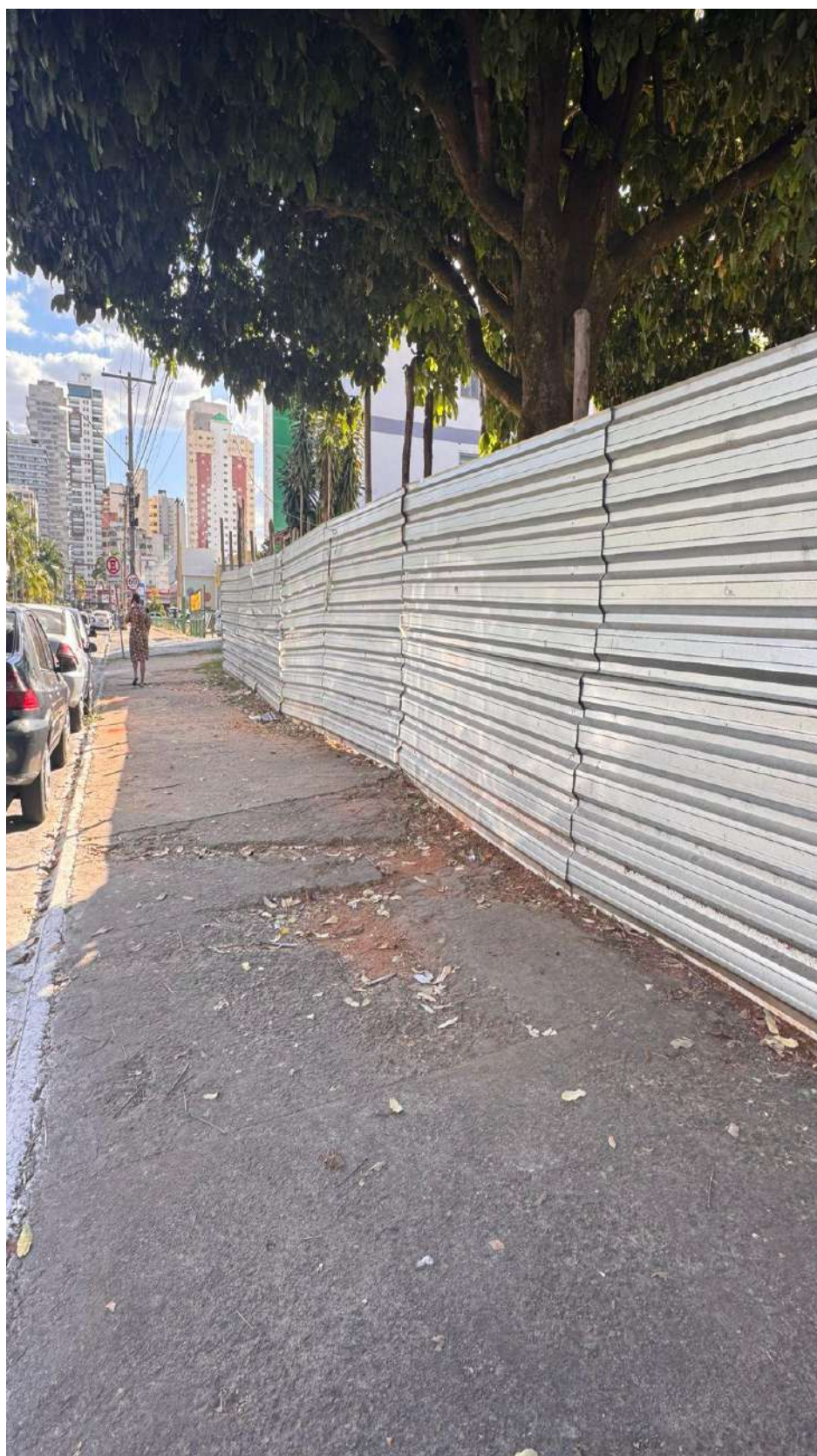
[Foto 13/14: Calçada de entrada sem piso tátil e com áreas danificadas, 18/06/2025]
