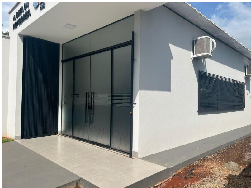
Figura 2 - Exemplo de subseção que consta brise nas janelas e porta metálica "camarão" recuada.
