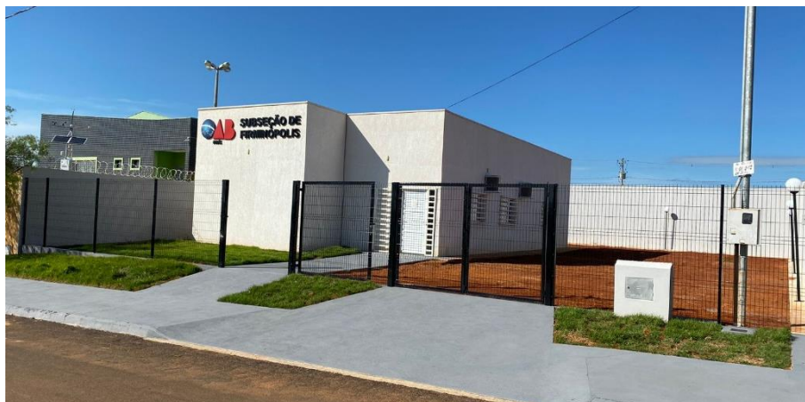
Figura 2- Exemplo de subseção que consta o gradil na fachada frontal.
