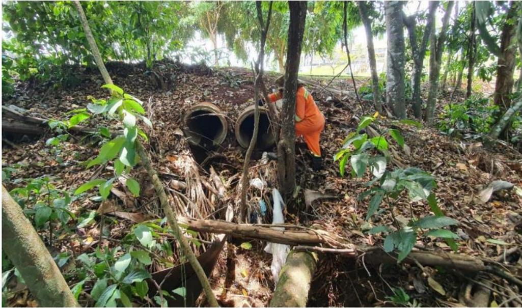
*Figura 4 - Lançamento de água pluvial (Tubo 2)*
